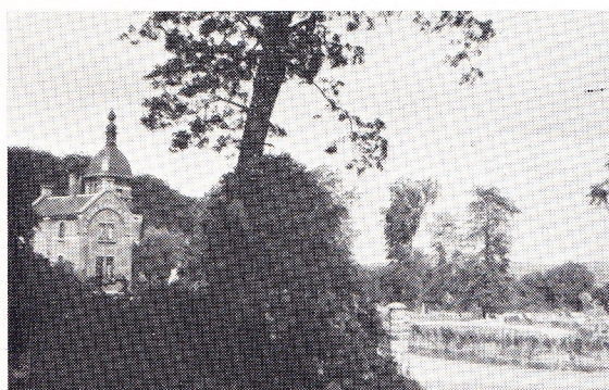
Entrée avenue G. Fauré
